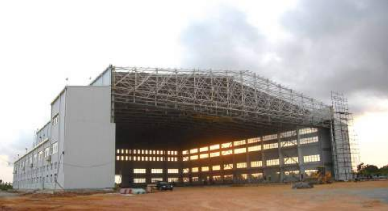
加纳国防部TAKORADI空军机库 TAKORADI Air Force Hangar of Ghanaian Ministry of National Defense 建筑面积: 13000m 2 Construction area: 13,000m 2 结构形式: 钢框架结构 Structure type: Steel-frame structure 钢构吨位: 1300T Tonnage of steel structure: 1,300T 竣工时间: 2012年 Completion time: 2012
