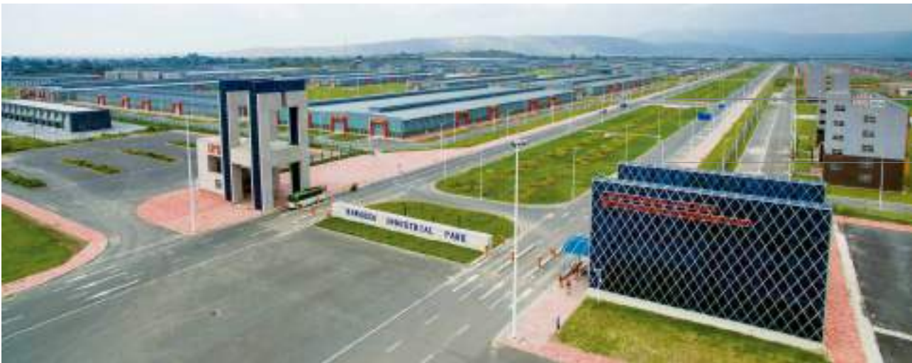
埃塞俄比亚哈瓦萨（HAWASSA）工业园 Ethiopia (HAWASSA) Industrial Park 建筑面积: 128000m 2 Construction area: 128,000m 2 结构形式: 门式刚架 Structure type: Portal frame 钢构吨位: 4000T Tonnage of steel structure: 4,000T
